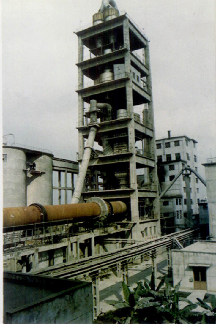
湔江水泥厂窑外分解工艺窑尾系统
