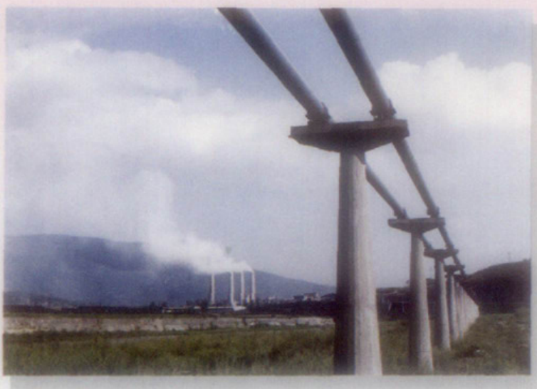
江油水泥厂料浆输送管道
