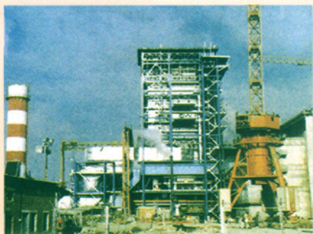
巴基斯坦古杜电站的680t/h燃油锅炉
